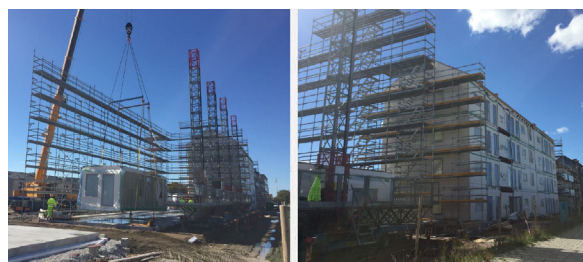
Obr. 6: Sestavování modulů BoKLOK na staveništi, Zdroj: Skanska, 2019
