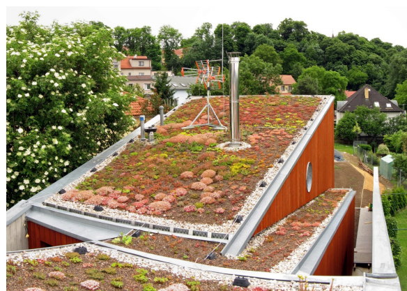
Obr. 4: Extenzivní zelená střecha na rodinném domě. Typ budovy je jedním z faktorů ovlivňující výsledky ekonomického hodnocení (Zdroj: Macháč et al., 2019)
